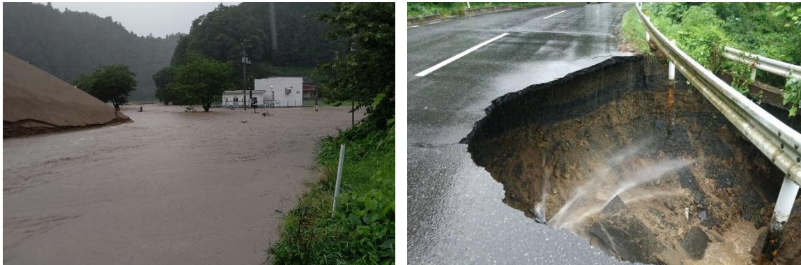
図表 43 浸水する米谷浄水場と道路陥没による管露出
