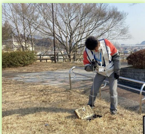
音聴棒で行う漏水有無の調査
